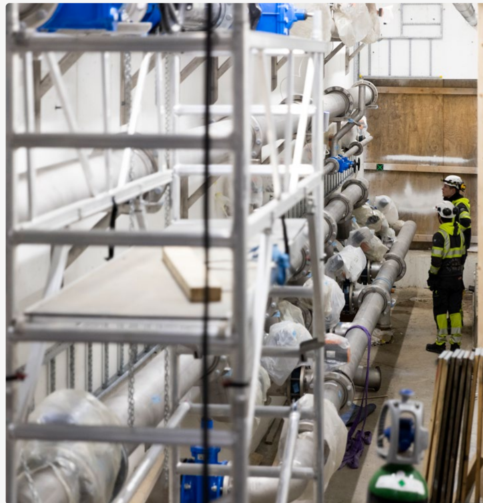
Mykje skal på plass ved Åreid vassreinseanlegg i samband med utbygging.
