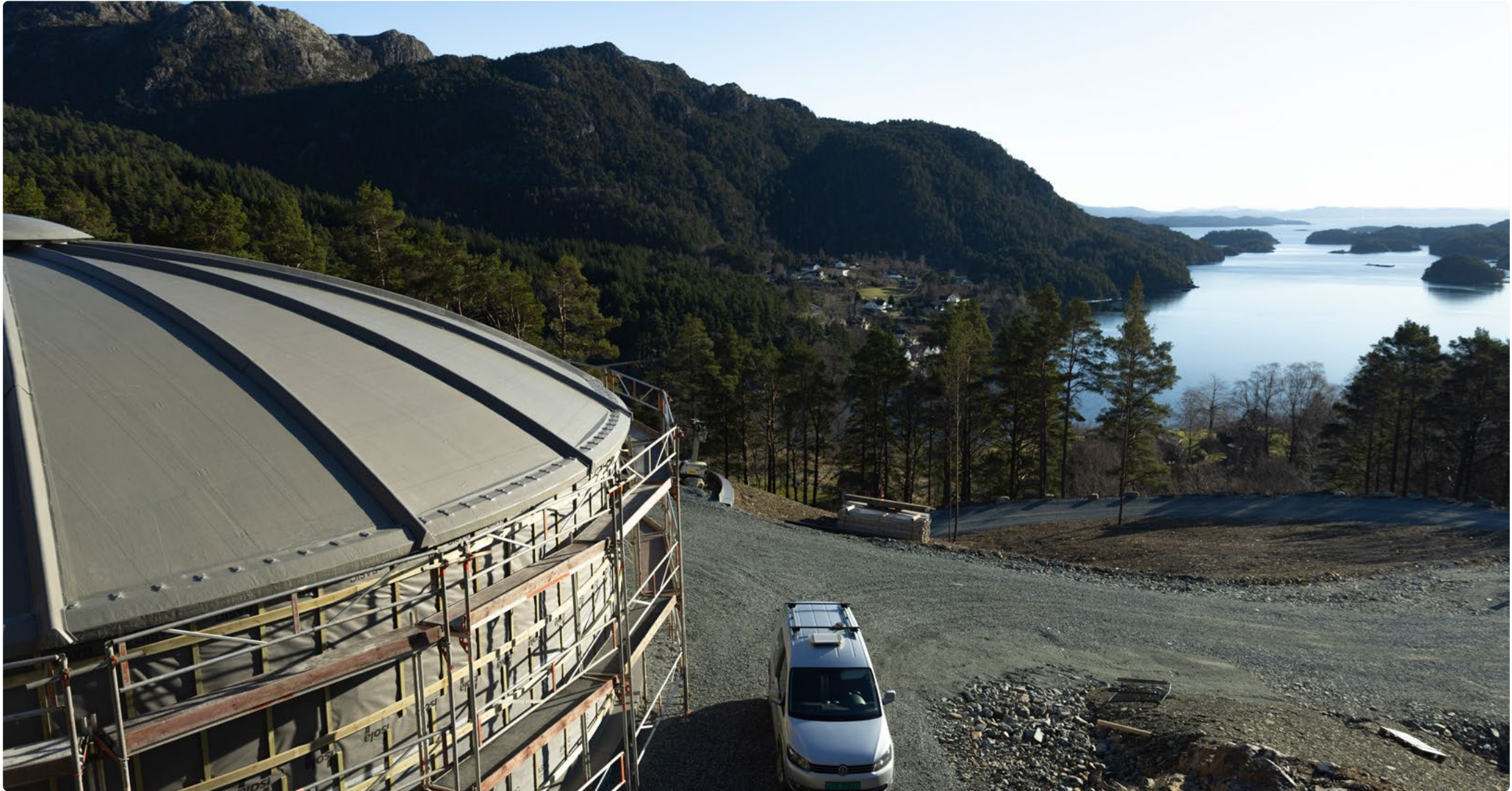
Bygging av nytt vassbasseng ved Åreid. Utsikt sørover mot Børøyfjorden.
