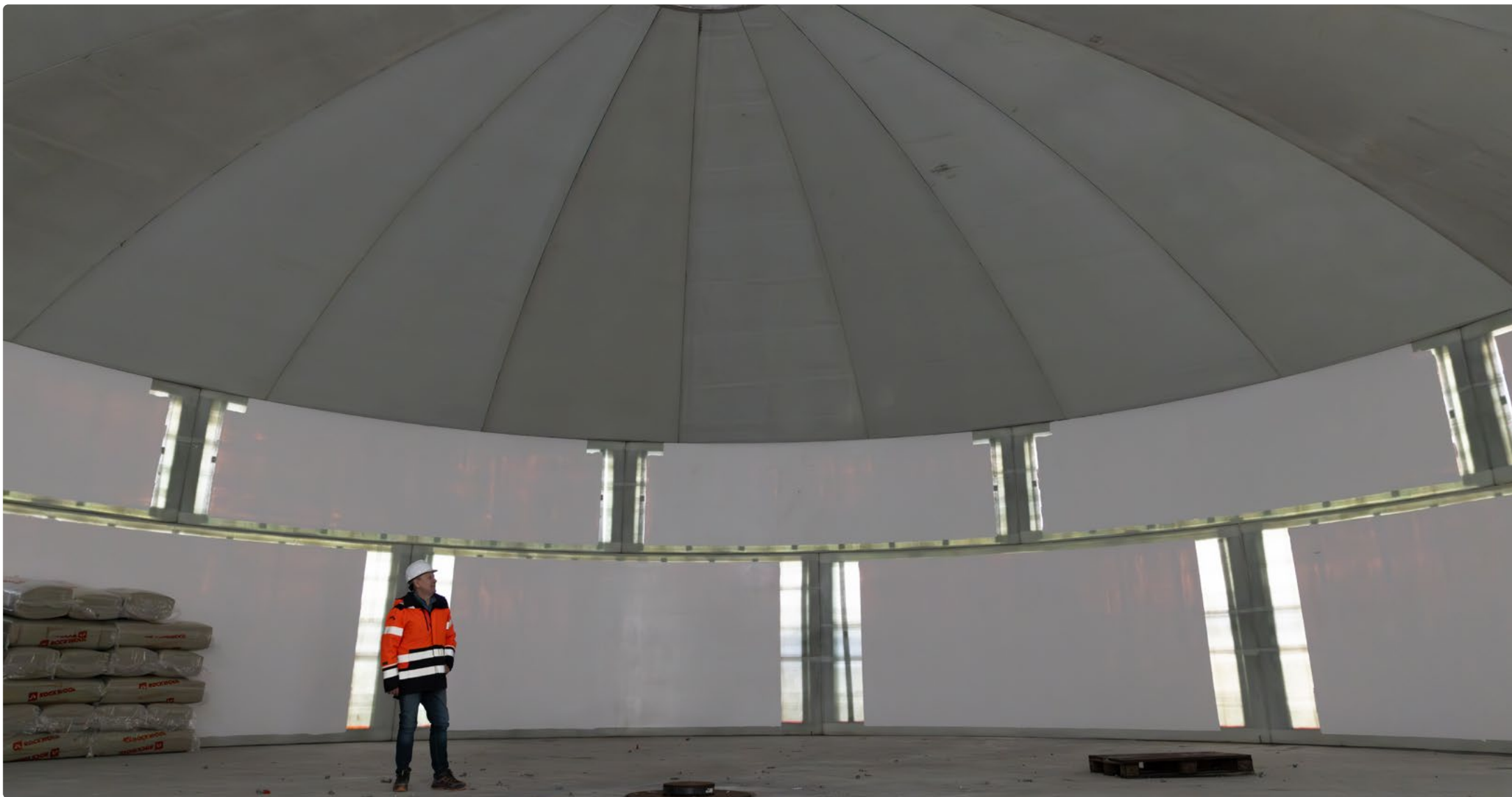
Fra innsida av nytt vassbasseng ved Åreid.
