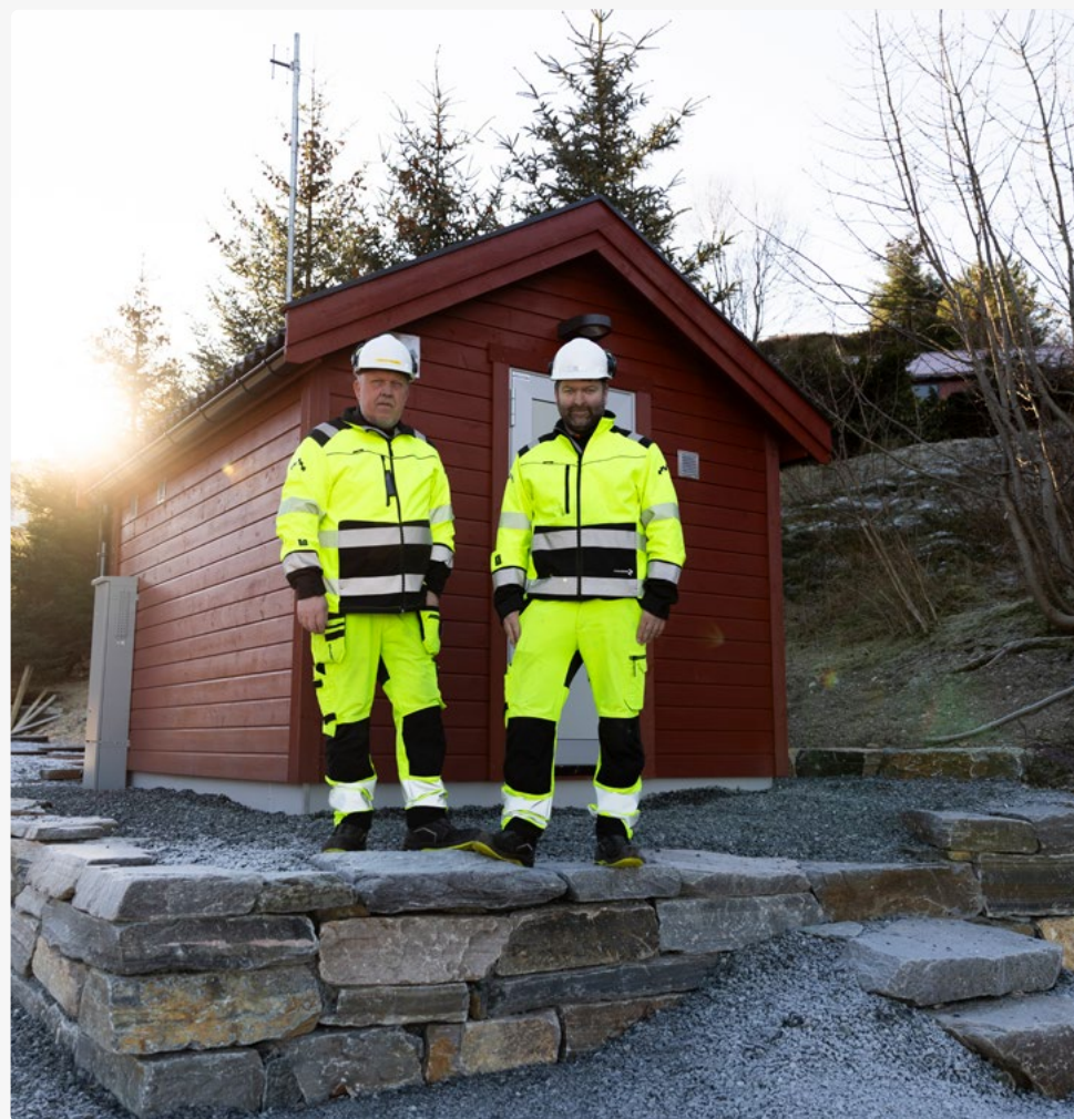
Driftsoperatørar Reidar Meling og Simon Rune Steinsbø framføre den nye kloakkpumpestasjonen på Rolfsnes.
