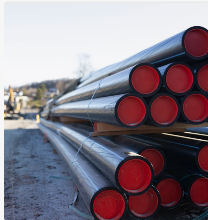
Mange meter med nye leidningar blir lagt i dei nye prosjekta. Her frå veganlegget på Moster.
