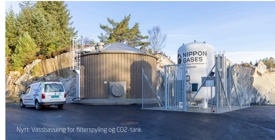
Nytt: Vassbasseng for filterspyling og CO2-tank.
