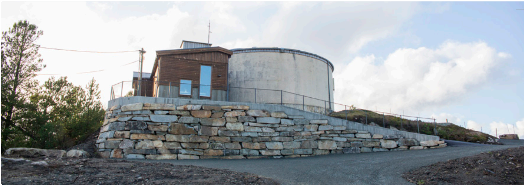
Ombygging av høgdebassenget på Hammaren blei ferdigstilt i 2021.
