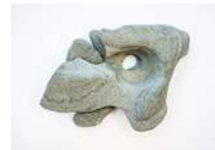
Vassrøyrret som låg over denne steinen var lekk i over 30 år. Trykket og mengdene med vatn har gjort at det har blitt eit hol rett gjennom steinen!
